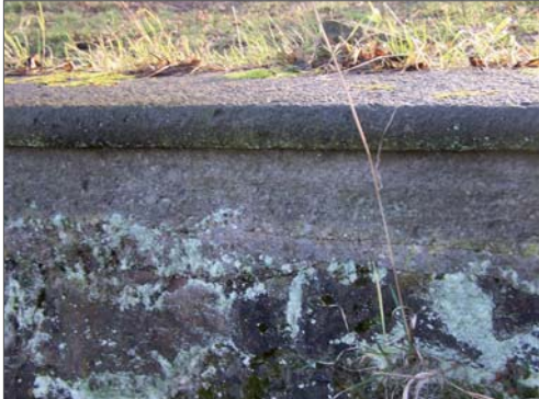
Abb. A81 (links oben) _ Ein Abschnitt der nachträglich ergänzten simplen Natursteinabdeckung des unteren Beckens.
