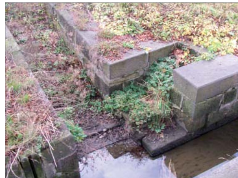
Abb. A47 (rechte Seite, links unten) _ Eine dritte kleine Treppe bietet einen Zugang aus Richtung der Prälatur. Die Treppenwange ist hier teilweise eingestürzt und das Natursteinmauerwerk mit Ziegelresten ergänzt. Es finden sich Reste einer weiteren Regulierungseinrichtung.
