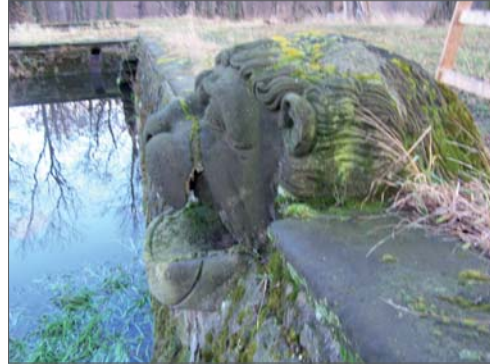
Abb. A71 (oben Mitte) _ In der Seitenansicht sind die wiederangebrachten Kopfpartien und Fehlstellen deutlich zu erkennen.
