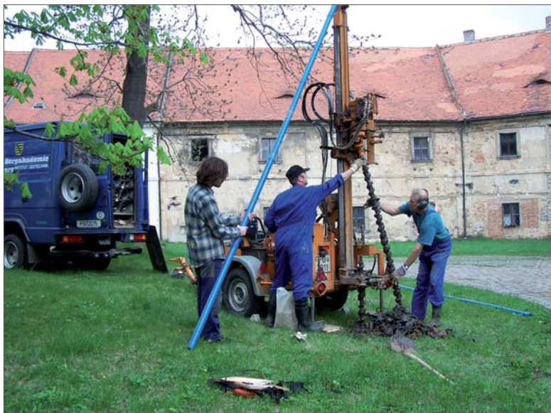
Abb. 4.4 _ Techniker der TU Bergakademie Freiberg beim Setzen der Grundwassermessstellen im Wirtschaftshof.
