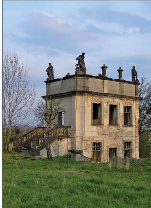
Abb 1.9 _ Einer der durch Setzungserscheinungen stark geschädigten Pavillons im Konventgarten.
