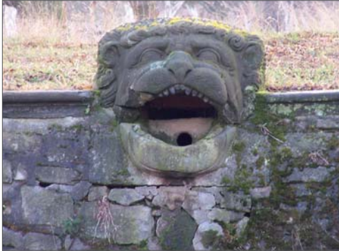
Abb. A69 (oben links) _ Der Wasserspeier im oberen Fischbehälter. Deutlich zu sehen ist das nachträglich eingebaute Rohr.
