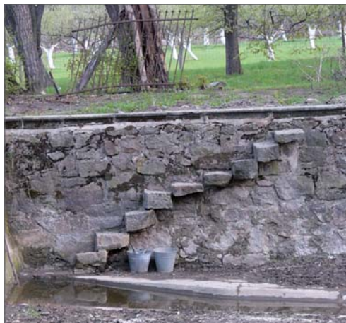
Abb. A60 (links unten) _ Auch in der südöstlichen Ecke, an der tiefsten Stelle des Fischbehälters existiert eine Treppe aus „fliegenden Stufen“. Im Vordergrund ist die Beton-Rinne zu sehen, die aus den Baumaßnahmen nach Planungen von 1969 stammt (vgl. Abb. A75).
