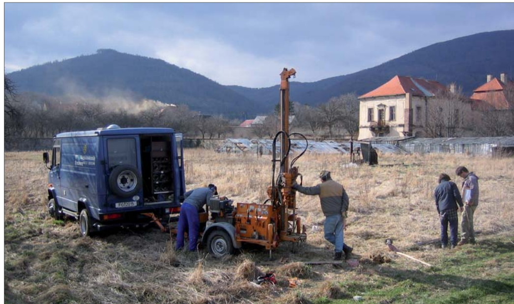
Abb. 4.2 _ Rammkernsondierungen im Oberen Konventgarten.
