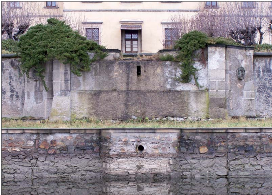
Abb. A113 (oben) _ Lage der mutmaßlichen Kaskade und der Speier an der obersten Stützmauer des Abgartens.
