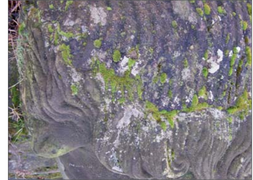
Abb. A73 (oben rechts), Abb. A74 (unten rechts) _ In der Draufsicht ist gut erkennbar, dass bei beiden Speiern die verlorengegangenen originalen hinteren Kopfpartien grob aus Beton nachmodelliert wurden.
