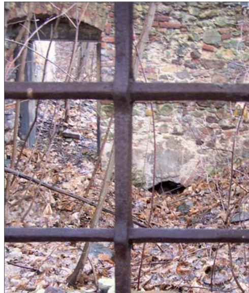
Abb. A177 (rechts unten) _ Der Kanal unterhalb des Mühlrades, der das benutzte Wasser sammelte und abführte.
