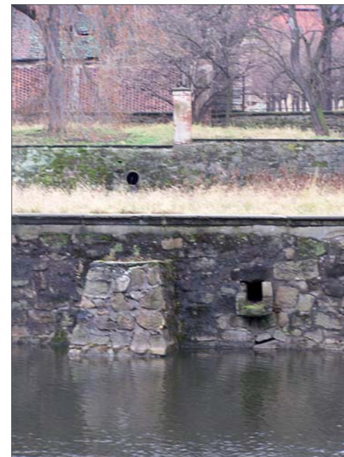
Abb. 5.26 _ Der Überlauf vom Oberen in den Unteren Fischbehälter, der heute verschlossen ist.
