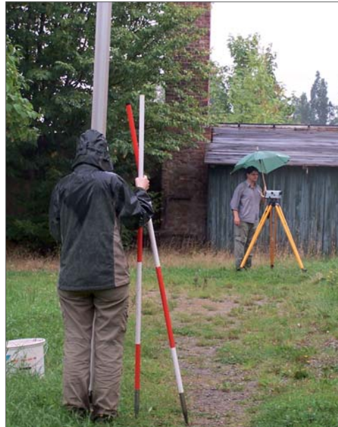
Abb. 4.1 _ Beim Feinnivellement zur Setzungsmessung am Sommerflügel.
