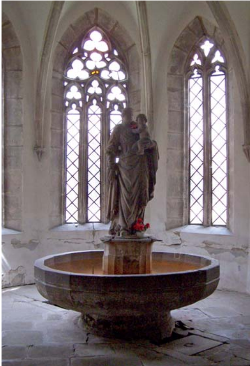
Abb. 5.8 _ Das Brunnenhaus im Kreuzgang - vorn rechts im Bild ist auch eine Steinplatte zu sehen, die einen Schacht mit verschiedenen Leitungen abdeckt.
