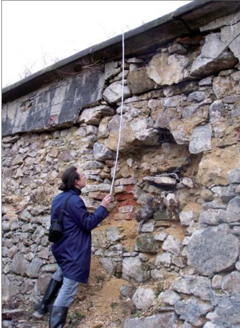
Abb 1.11 _ Rissbildung und der negative Einfluss von Wasser haben die große Mauer im Abtgarten stark beschädigt.
