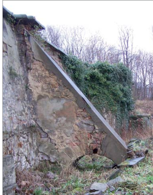
Abb. A158 (links) _ Seitenansicht der Großen Kaskade und der Aufweitung des Kanals zum Becken.
