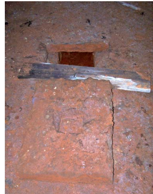
Abb. 5.30 _ Mit Steinplatten abgedeckter Kanal im Keller des Malzhauses.
