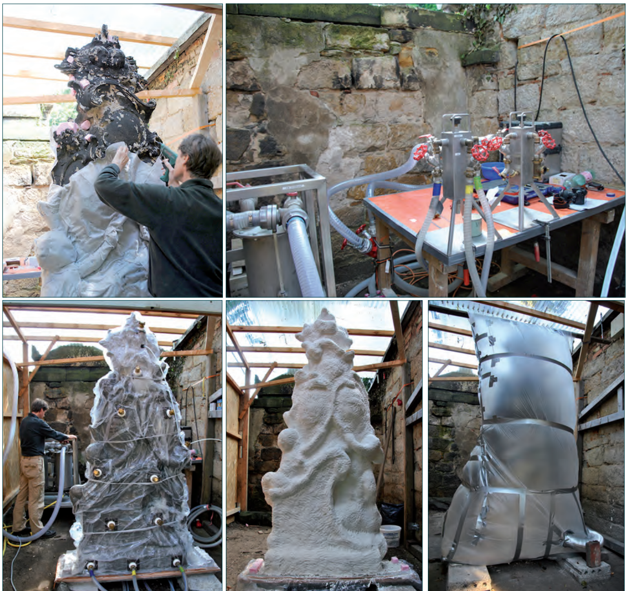
Abb. 20 Maßnahmen zur Entsalzung der Grabplatte, oben v.l.n.r.: Schutz der Oberfläche mit einem Vliesbelag vor dem Einschweißen in Plastikfolie; Apparatur zur Entsalzung; unten v.l.n.r.: in Folie eingeschweißte Grabplatte während des Entsalzungsvorgangs (Ansicht von der Vorderseite mit Schlauchanschlüssen für die Wasserzufuhr); Auflage einer Zellstoffkompresse auf das nasse Objekt unmittelbar nach Entfernung der Plastikhülle im Anschluss an die Unterdruck-Entsalzung, aktive Trocknung aufgrund von Restfeuchte nach natürlicher Trocknung.
