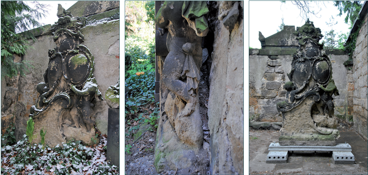
Abb. 5 Aktueller Standort mit Zustand 2012. Umsetzung und Fixierung des Grabmals auf ein Streifenfundament zur Stabilisierung für die anschließende Entsalzung und Festigung (rechts).
