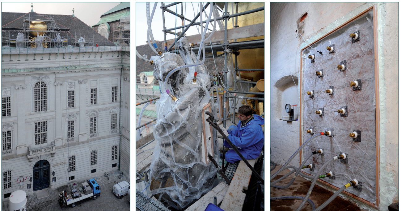
Abb. 84 In-situ Festigung einer 3 m großen Attika-Figur auf der Nationalbibliothek/Hofburg Wien, die zur Konservierung nicht entfernt werden konnte. Zwei Geräte, jeweils auf dem LKW und an der Skulptur wurden gekoppelt und es wurde eine Höhe von 30 m überwunden (erstes und zweites Foto). Entzaltung einer Ziegelmauer im Johanniskloster in Stralsund (rechtes Foto, Fotos: Erich Pummer).
